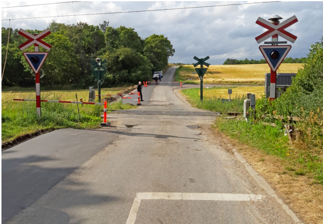
Overkørslen efter ulykken. Set fra bilistens retning. Bemærk afspærringen i venstre side, bomdrevet - uden bom - i højre side og de løse kabler bag signalerne.
