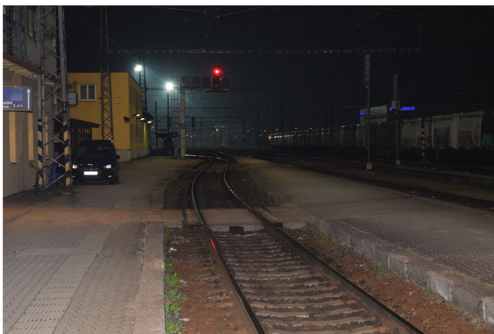
Obr. č. 3: Cestové návěstidlo Lc5b na krakorci
