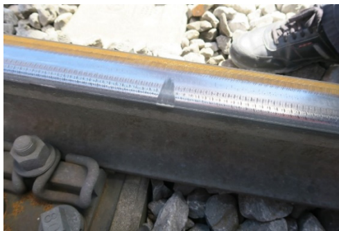
Abbildung 30: Beispiel eines auf die Schienenfahrkante übertragenen Schmierfilms. In der Mitte; Daumenabdruck zur Kontrolle des vorhandenen Schmierfilms.
