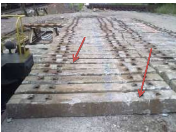
Figura 14 Segni di rotolamento delle ruote sulle traverse sequestrate (Foto RFI)
