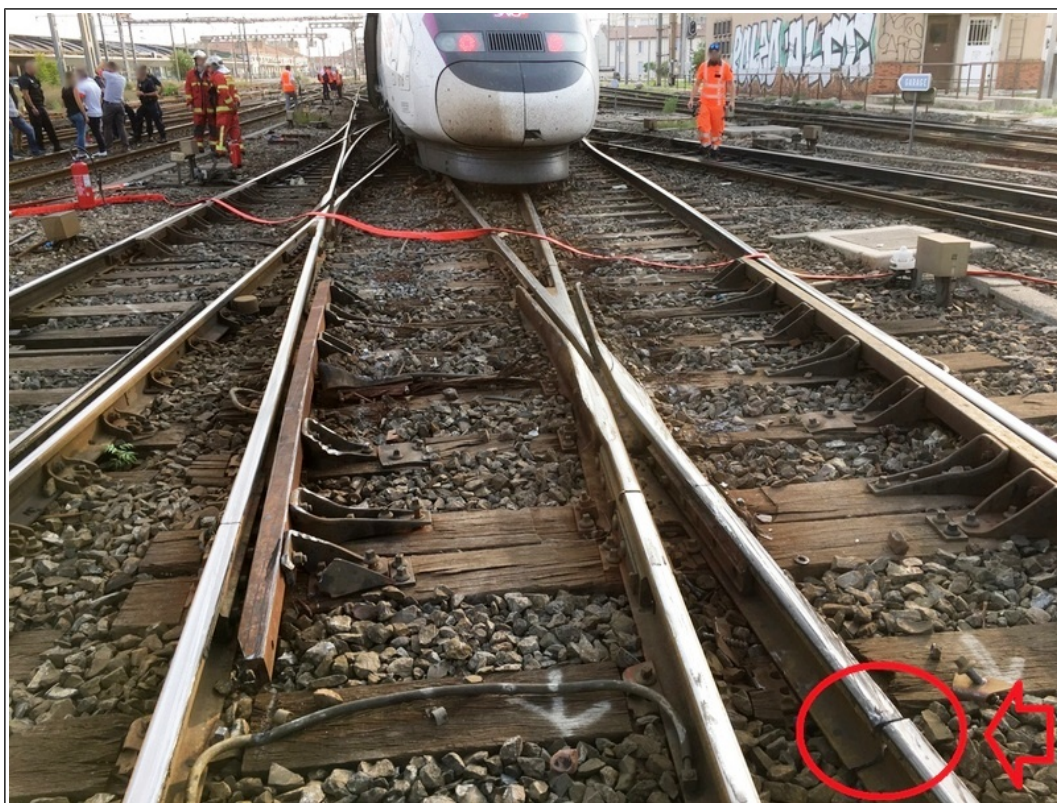
Figure 2 : l'arrière de la rame qui a déraillé. Au premier plan à droite, cerclée en rouge, la rupture de rail
