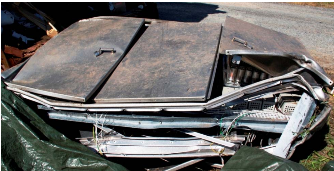
Kuva 19 Tuhoutunut turvalaittekaappi K266.
