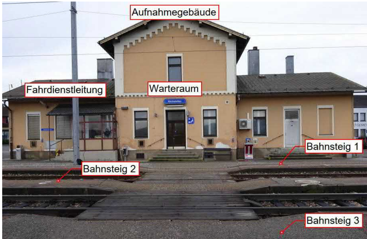
Abbildung 3 Aufnahmegebäude des Bf Kirchstetten (schienenseitig)
