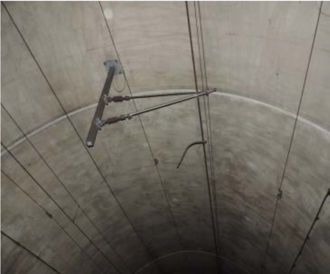
Abbildung 17: Beschädigung eines Oberleitungsauslegers durch die Seiteneinstiegstür (Quelle IM)
