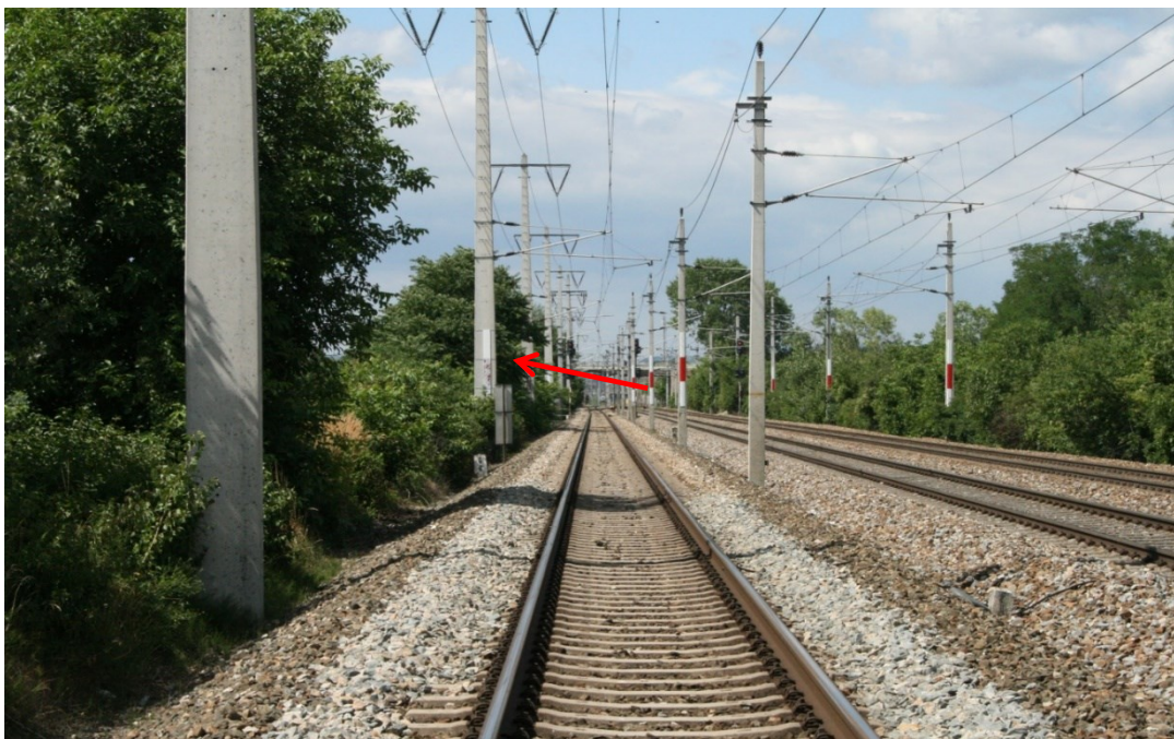
Abbildung 17: Sicht auf die ES Bf Leopoldau aus einer Entfernung von 200 m(Quelle SUB)
