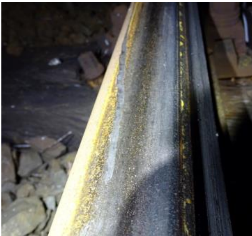
5. ábra: sínkoronán kezdődő nyom a bal sínszálon, az A-B aljak között
