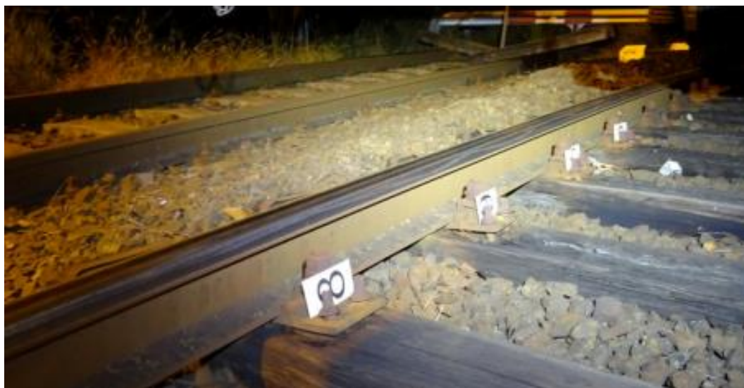
4. ábra: Hullámos mászásnyom a 8-B aljak között
