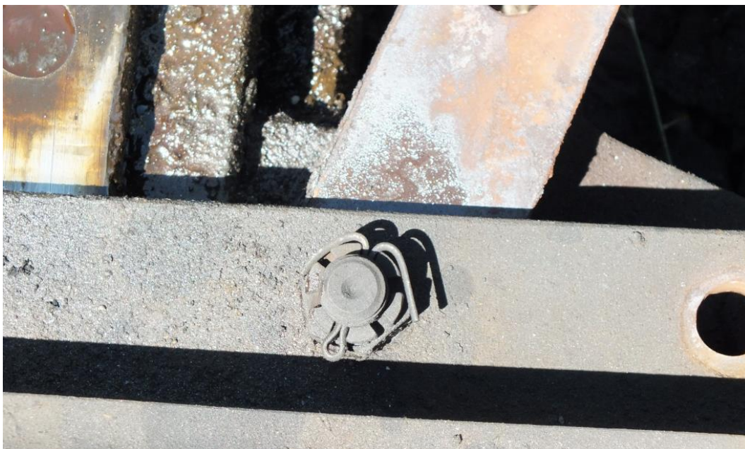
8. ábra: a csúcssínfűl másik, laza rögzítőcsavarja
