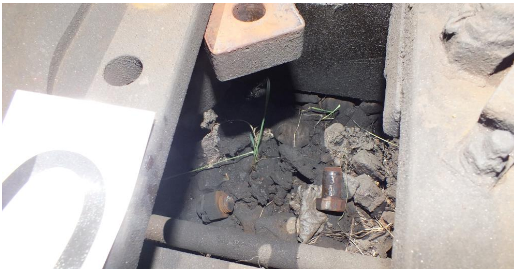
5. ábra: csavartöredékek az ágyzatban
