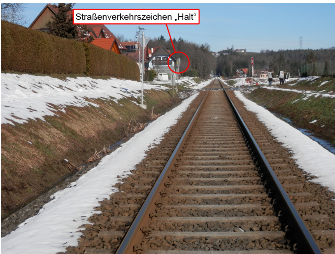
Abbildung 18: Blick in Fahrtrichtung von Z 4382 bei ca. km 36,5 (Quelle SUB)
