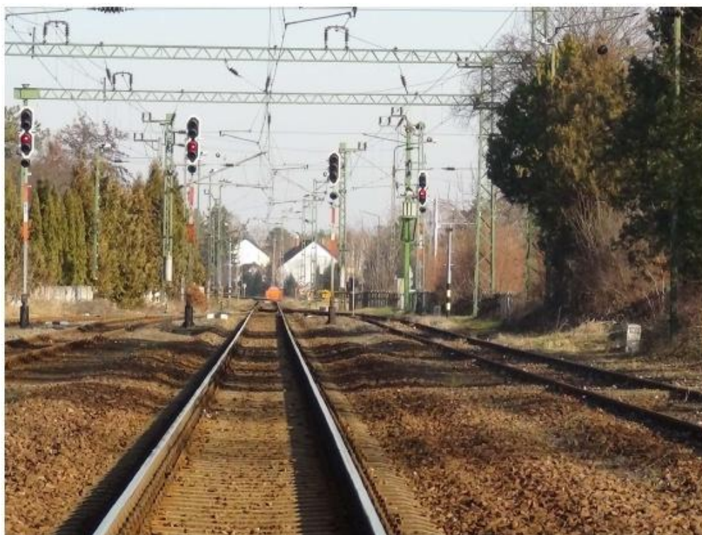
8. sz. ábra: A kezdőpont felőli kijárat jelzők jelzései, valamennyi jelzőn „Megállj!” jelzés van.
