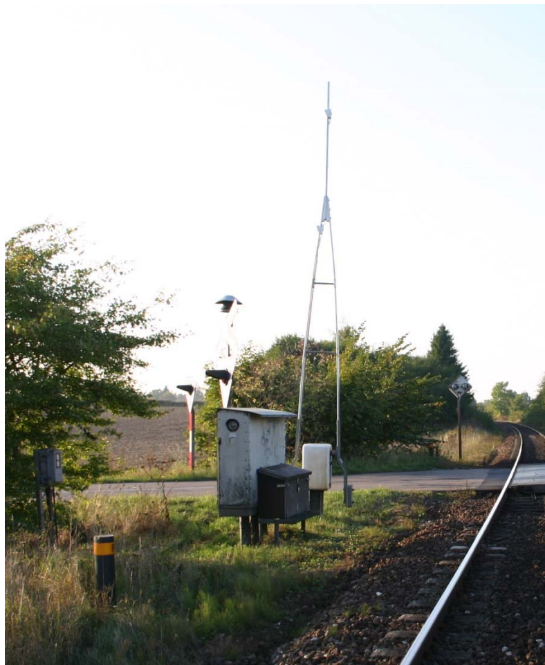
Foto 7 Overkørselsanlægget set fra øst - 2005
