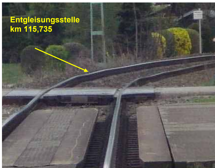
Abbildung 29 Gleislage im Bereich der Entgleisungsstelle
