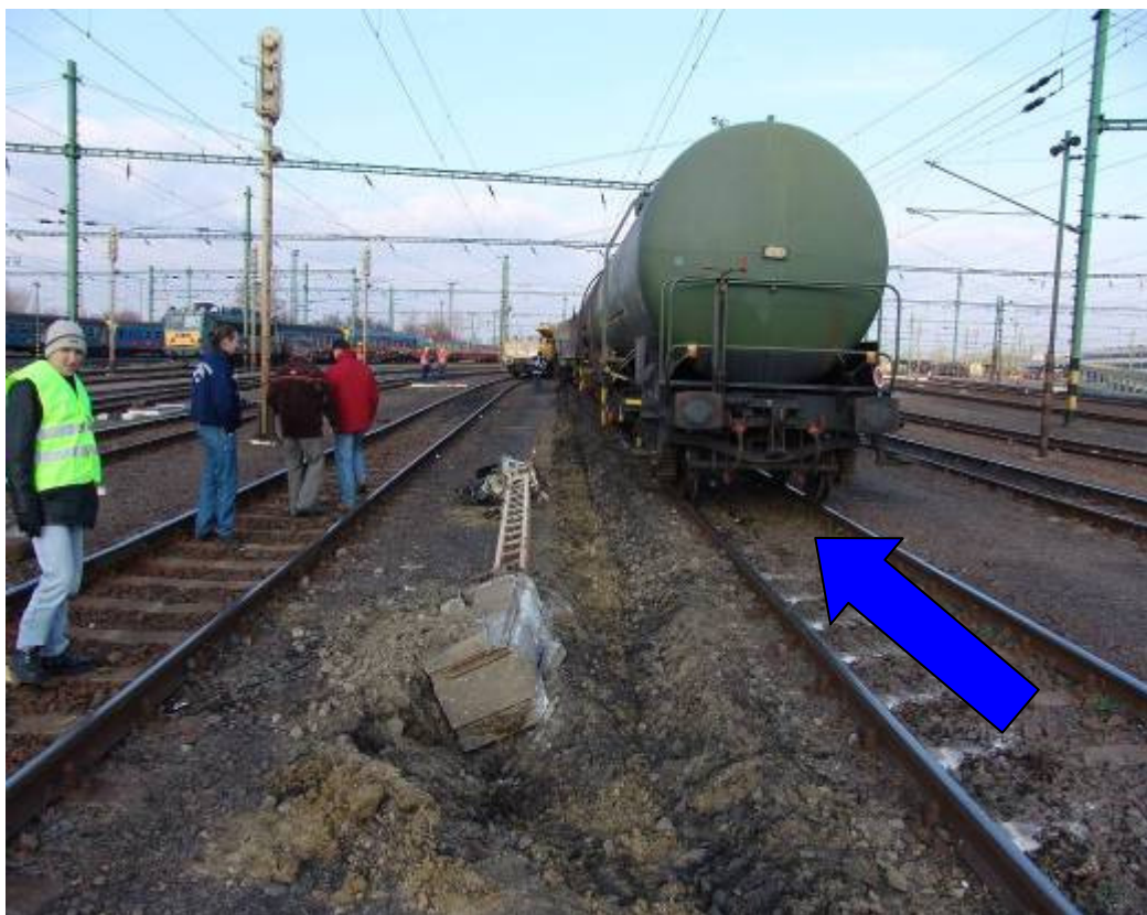
8. ábra: A sérült pálya és a kidöntött K18 jelű fényjelző
