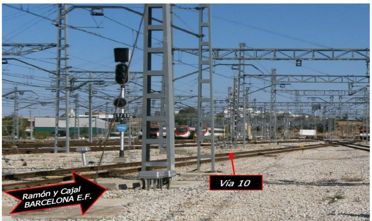
SEÑAL DE SALIDA S1/10. DETALLE. (Fuente: ADIF)
