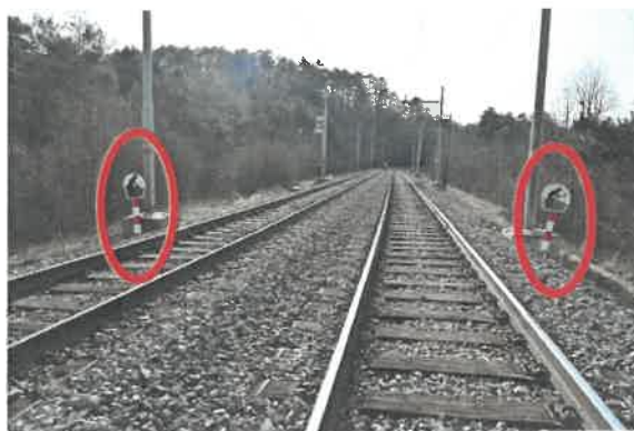
Slika: Z rdečima elipsama sta označena progovna opozorilnika, ki sta bila iz smeri Postojna pravilno nameščena na vsaki strani proge.
