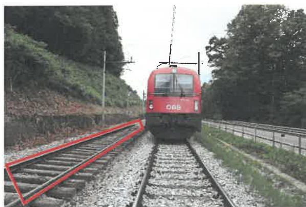
Slika št. 2: Slika prikazuje mesto ustavitve čela mednarodnega potniškega vlaka št. 211 po nesreči, v km 554.787, v rdečem rombu pa je prikazano področje presejanega z gramozom nezasutega dela levega tira.
