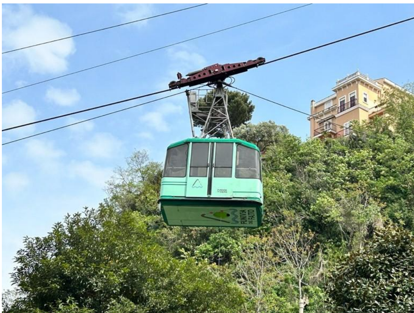
Caduta cabina della funivia bifune Castellammare di Stabia - Monte Faito (NA) - 17/04/2025.
