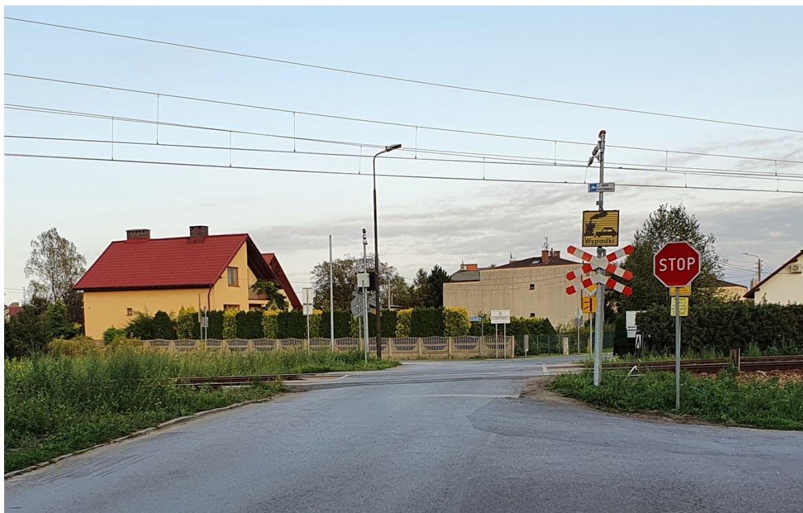
Rys. 1. Przejazd kolejowy w Imielinie z działającym systemem SPW-1M
