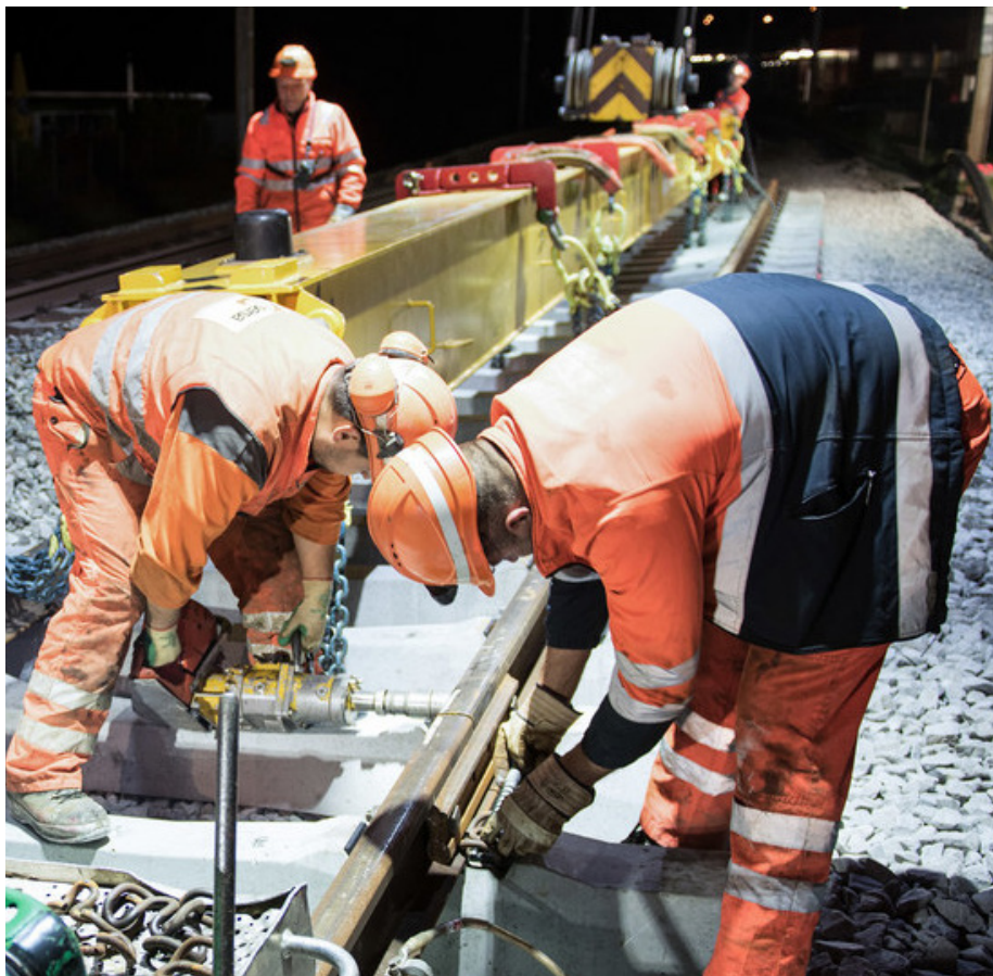
Les contrôles d'exploitation de l'OFT aident à améliorer la sécurité des postes de travail, notamment pour les ouvriers de la voie.
