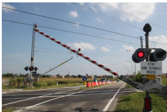
PL km 12+413 tratta Caluso-Chivasso Dispositivo luminoso a due luci rosse lampeggianti alternativamente (fonte DiGiFeMa – sopralluogo in data 07.08.2018)
