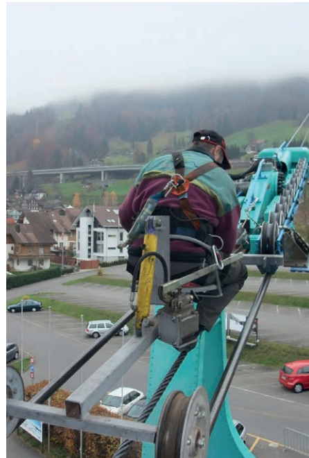
Il controllo visivo delle funi serve a individuare la presenza di danni alla superficie di funi o cavi.
