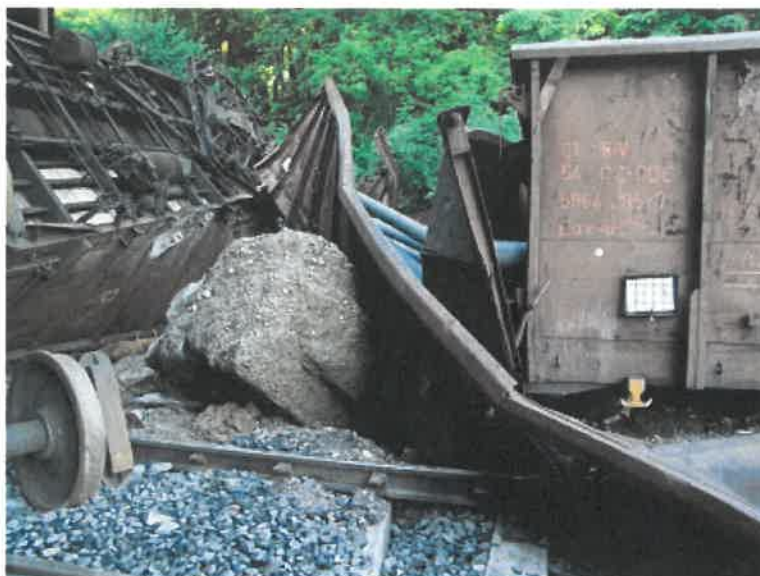
Slika: Uničeni vagoni, ki so se nagrmadili v zaključku tira št. 601 postaje Kranj
