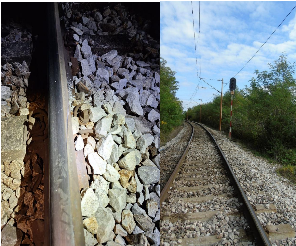
Slika 8. – Prvi trag iskliznuća (Izvor slike: AIN)
