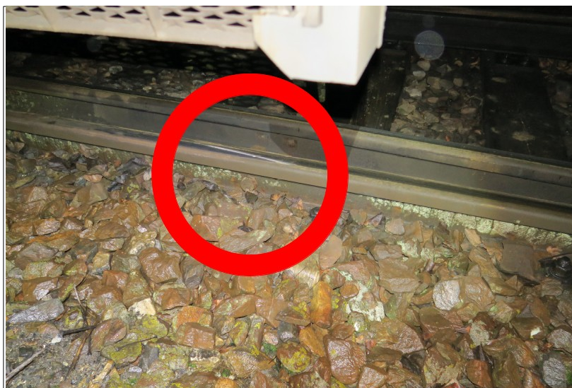
Obr. č. 4: Výhybka č. 6sv bod „0“
