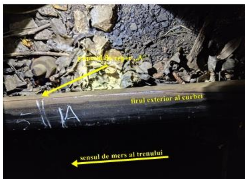
Foto nr.2: Punctul „A” – urmă de cădere la exteriorul căii (roata din partea dreaptă a osiei nr.1, în sensul de mers)
