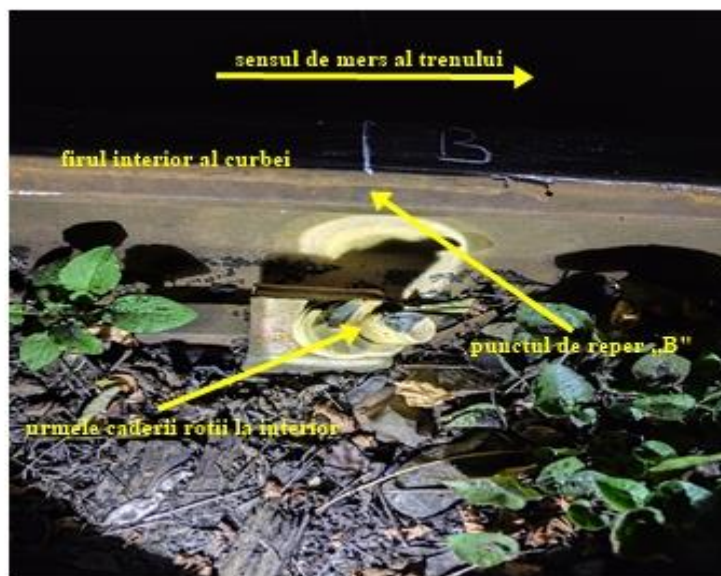
Foto nr.3: Punctul „B” – urmă de cădere la interiorul căii (roata din partea stângă a osiei nr.1, în sensul de mers)
