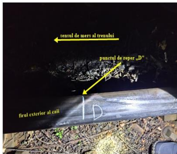
Foto nr.5: Punctul „D” – urma de cădere la exteriorul căii a roții din partea dreaptă a osiei nr.2, în sensul de mers
