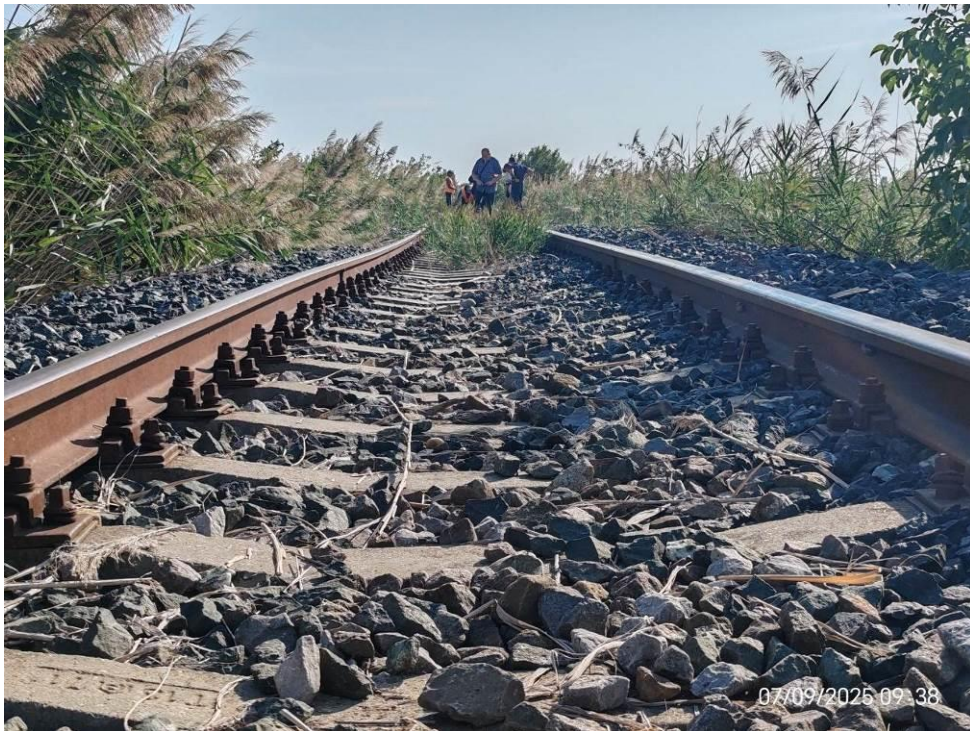
Foto nr.9 – Detaliu profil longitudinal fir stânga.
