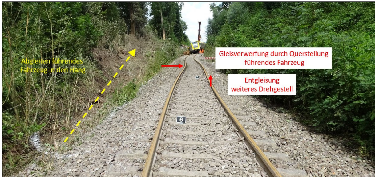
Abbildung 15: Weiterer Entgleisungsverlauf
