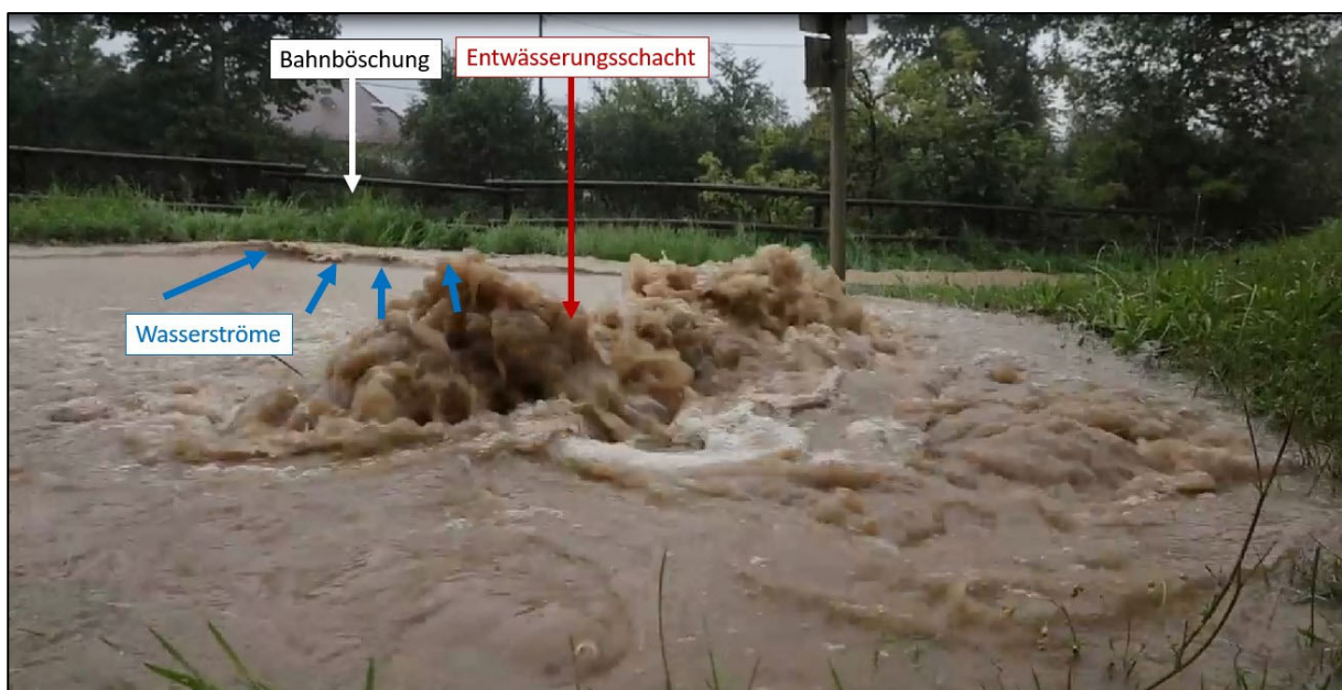
Abbildung 19: Überquellender Entwässerungsschacht 10
