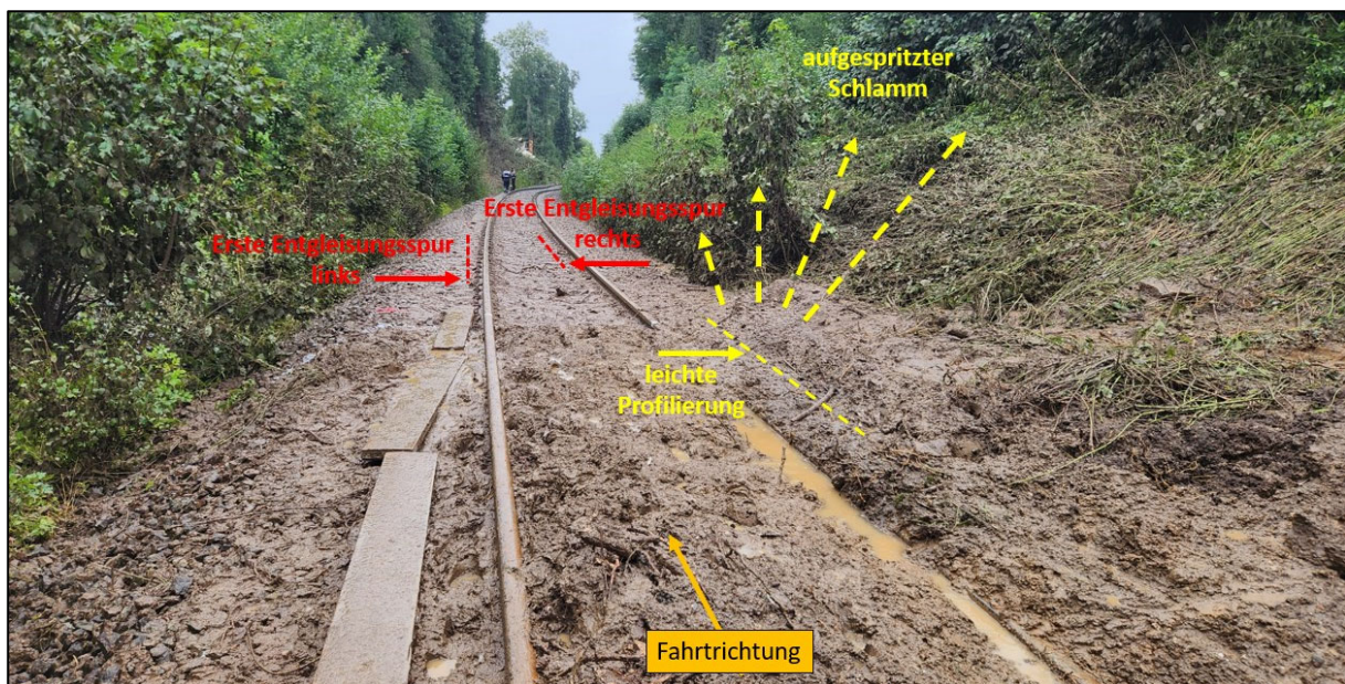
Abbildung 14: Nahaufnahme Entgleisungsstelle
