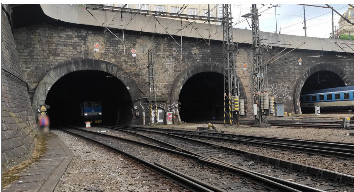
Obr. č. 5: Pohled na posunový díl HDV 362.114-1 stojící v konečném postavení po MU ve III. Vinohradském tunelu na výhybce č. 5. Zdroj: DI
