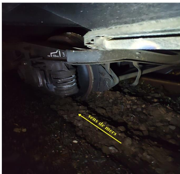
Foto nr.5 – Urme de rulare în stare deraiată în exteriorul căii
