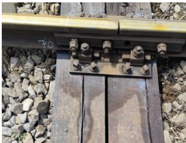
Foto nr.11 – Rosturile de dilatație
