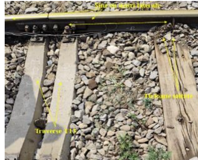
Foto.nr.8 – Traverse de beton T13
