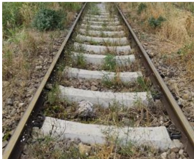
Foto.nr.10 – Piatra spartă colmatată cu vegetație
