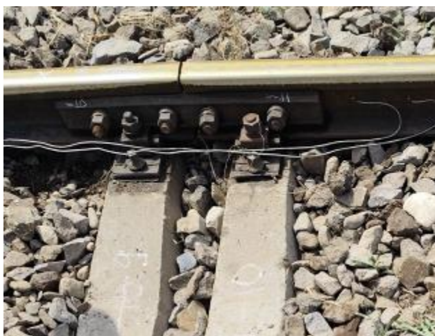
Foto nr.12 – Rosturile de dilatație
