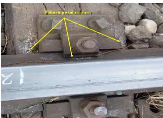
Foto nr.28 – Urmă de pilitură pe talpa șinei
