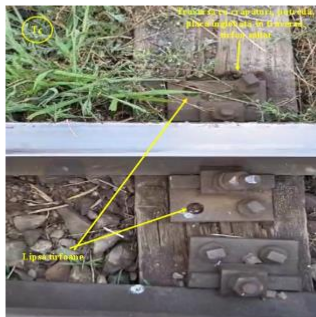
Foto nr.6 – Traversa T 6
