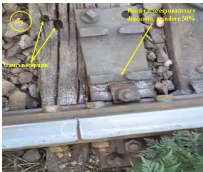
Foto nr.7 – Traversa T 8
