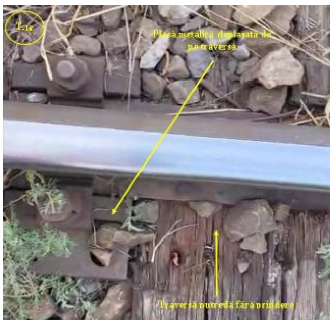
Foto nr.5 – Traversa T 16
