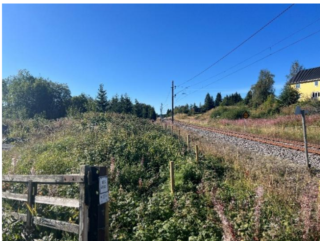
Figur 14: Sikt fra Gamme planovergang i retning Eina stasjon hvor toget kom fra. Foto: SHK
