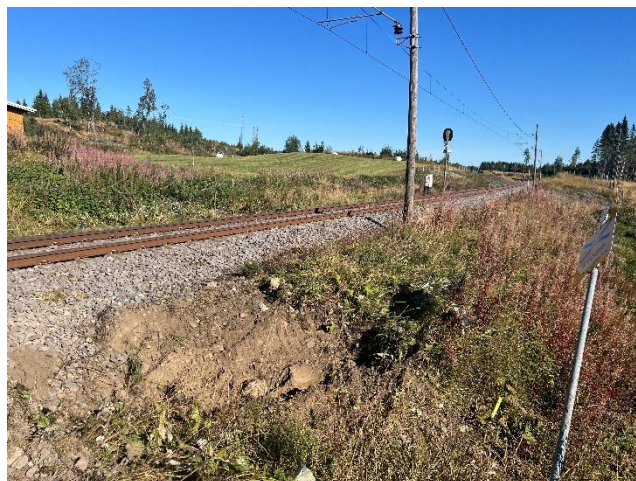
Figur 15: Sikt fra Gamme planovergang i retning Gjøvik. Foto: SHK
