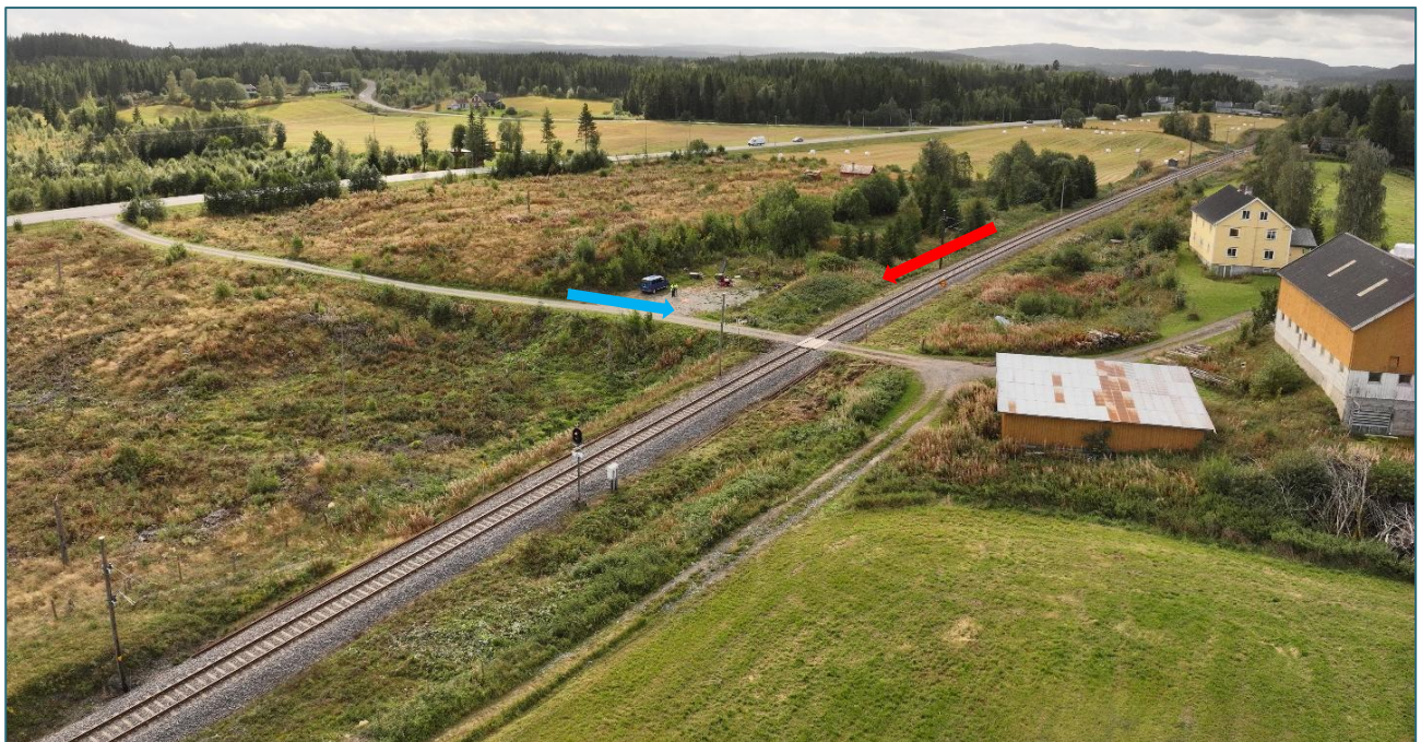
Figur 2: Gamle planovergang. Den blå pila viser retningen til traktoren. Den røde pila viser retningen til toget. Foto og påtegning: SHK
