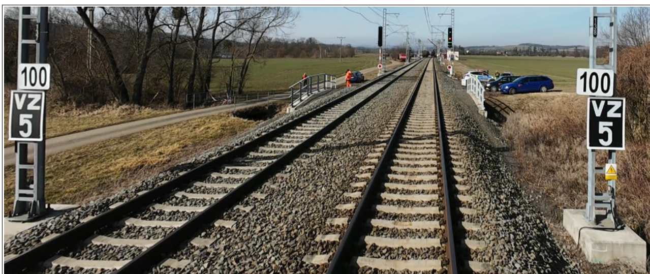
Obr. č. 23: Snímek z dronu zachycující mj. rychlostníky N s návěstí „Traťová rychlost“ s číslicí „100“ a v pozadí vpravo TK č. 2 umístěné vjezdové návěstidlo 2L žst. Hustopeče n. B. s návěstí „Rychlost 100 km/h a volno“. Vzdálenost mezi rychlostníky N a vjezdovými návěstidly 1L a 2L činila 54 m.
