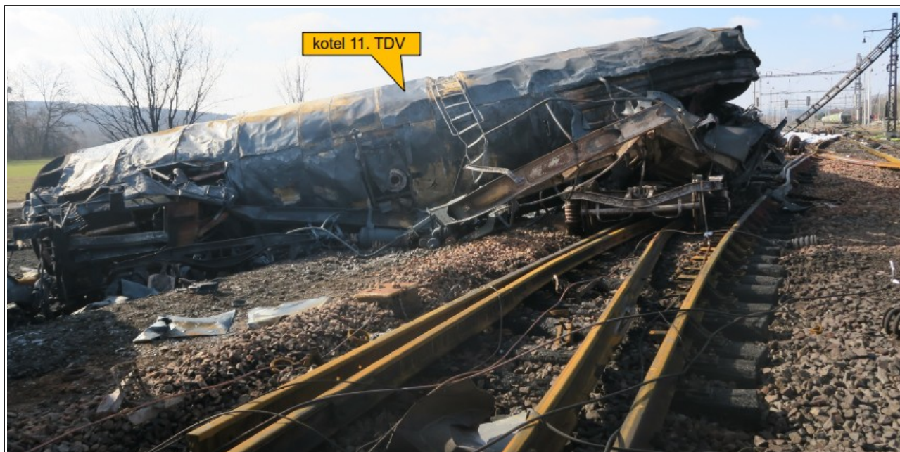
Obr. č. 12: Pohled na poškozenou výměnovou část výhybky č. 2 a destruovaný kotel 11. TDV
