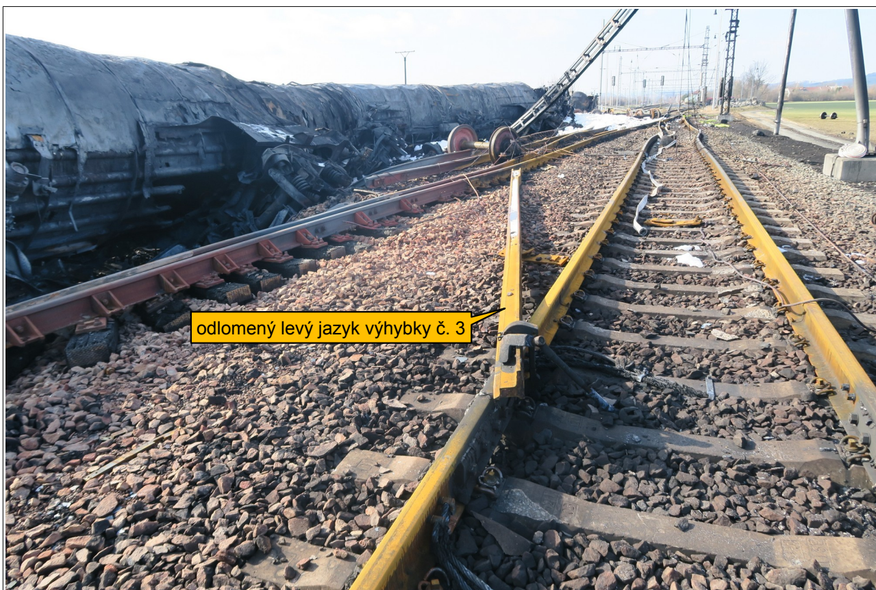
Obr. č. 34: Snímek zachycující odlomený levý jazyk výhybky č. 3 i s částí čelistového závěru
