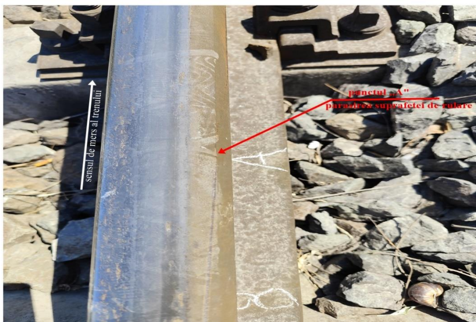
Foto nr.19 - Punctul de reper „A” – punctul de părăsire a suprafeței de rulare către exteriorul căii
