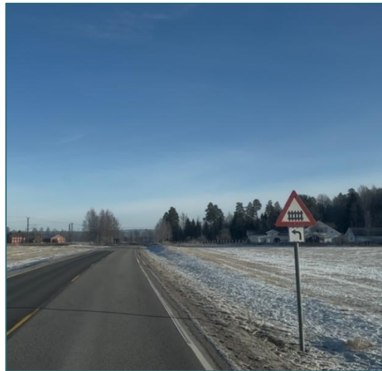
Figur 19: Feil oppsatt skilt langs fv. 175. Foto: SHK
