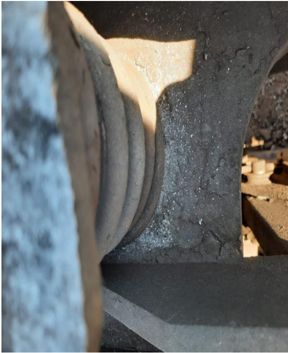
Foto nr.6 – Urme de pilitură pe cadrul boghiului
