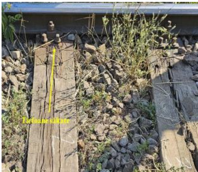
Foto.nr.9 – Traversele T-2, T-3
