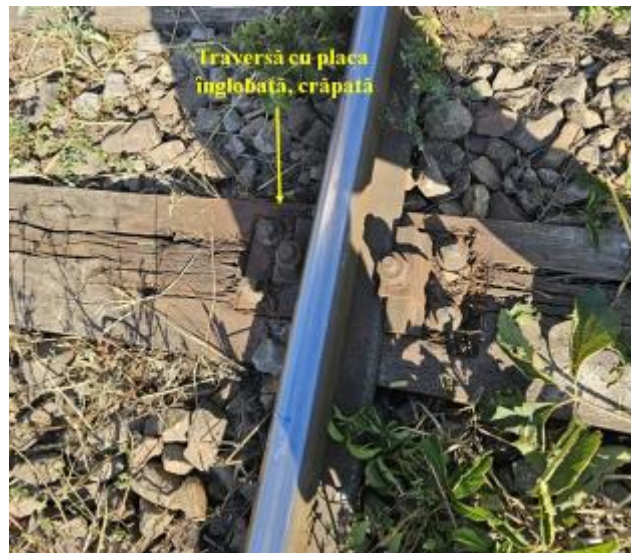
Foto.nr.10 – Traversa T-2 cu placa înglobată
