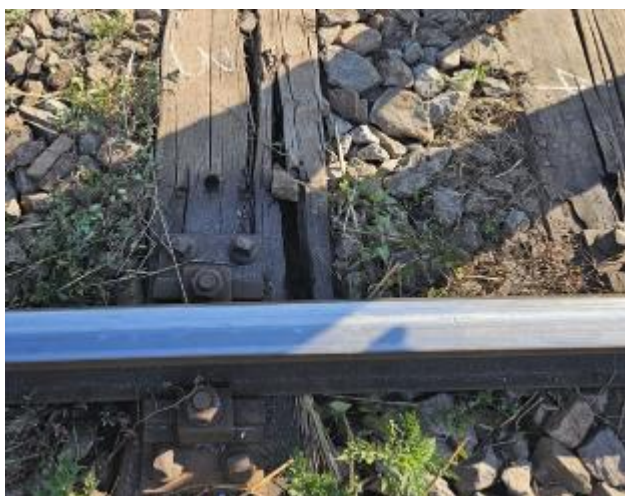
Foto.nr.11 – Traversele T-3, T-4
