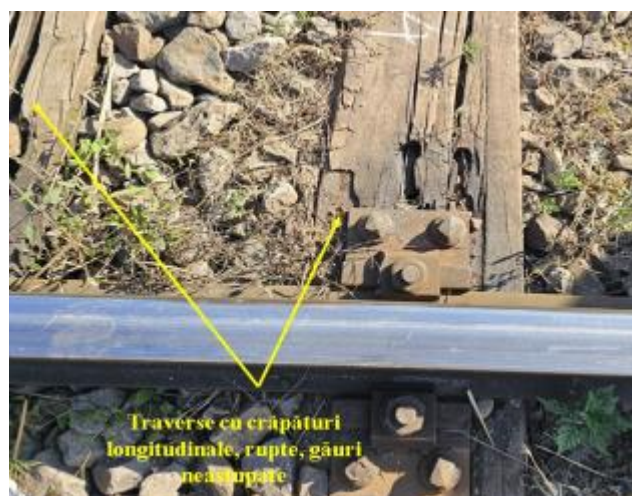
Foto.nr.12 – Traversele T-3, T-4
