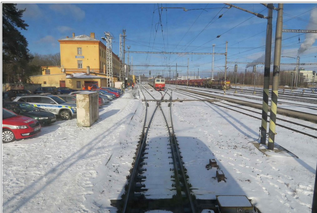
Obr. č. 7: Pohled ze sunutého posunového dílu po jeho zastavení
