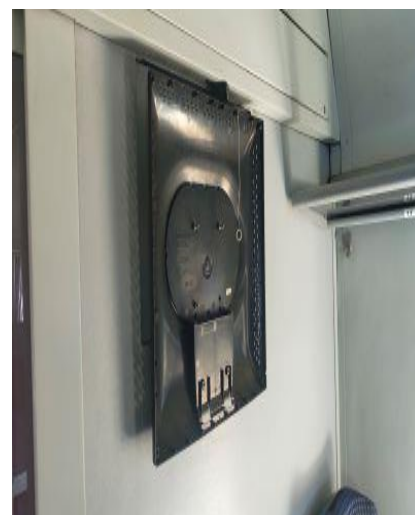
Foto nr.3 – Monitor căzut din suport
