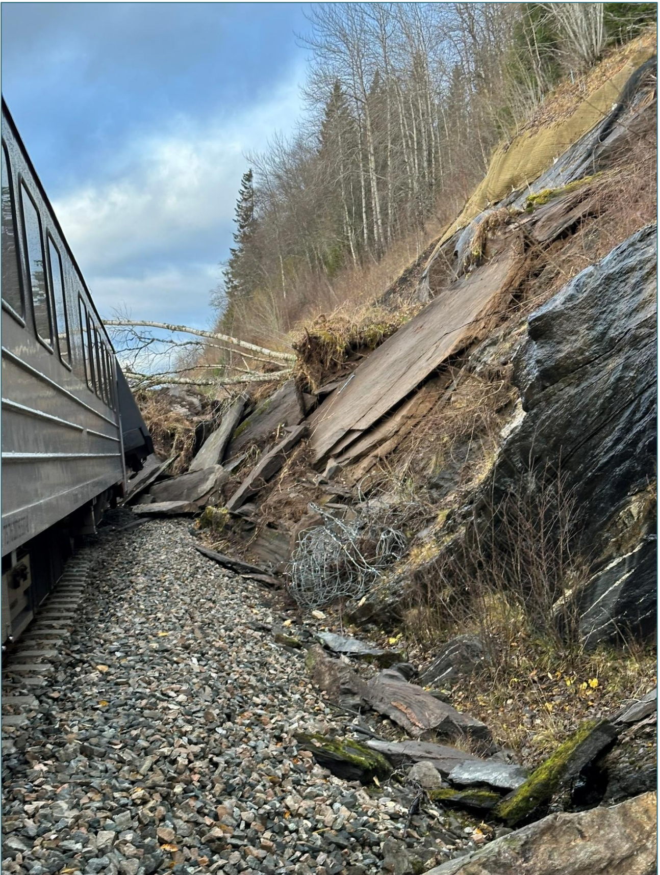
Figur 13: Skredet med wirenett. Foto: SHK
