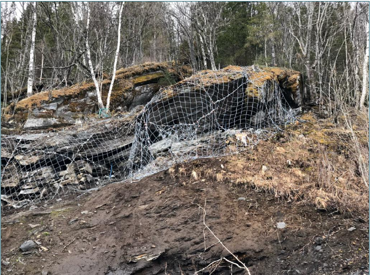
Figur 20: Fra sluttrapport bergsikring. Kilde: Sluttrapport Prosjekt 1641 – Finneidfjord Stasjon, 7.5.2018, Nordisk Fjellsikring
