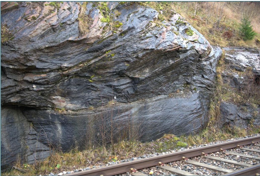
Figur 11: Berg på stedet viser jord og sandfylte slepper. Det er også innhold av silt- og leirfraksjoner. Foto: SHK
