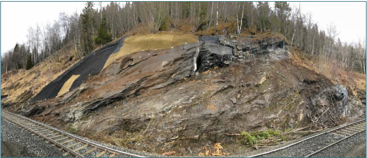
Figur 19: Fra sluttrapport bergsikring. Kilde: Sluttrapport Prosjekt 1641 – Finneidfjord Stasjon, 7.5.2018, Nordisk Fjellsikring
