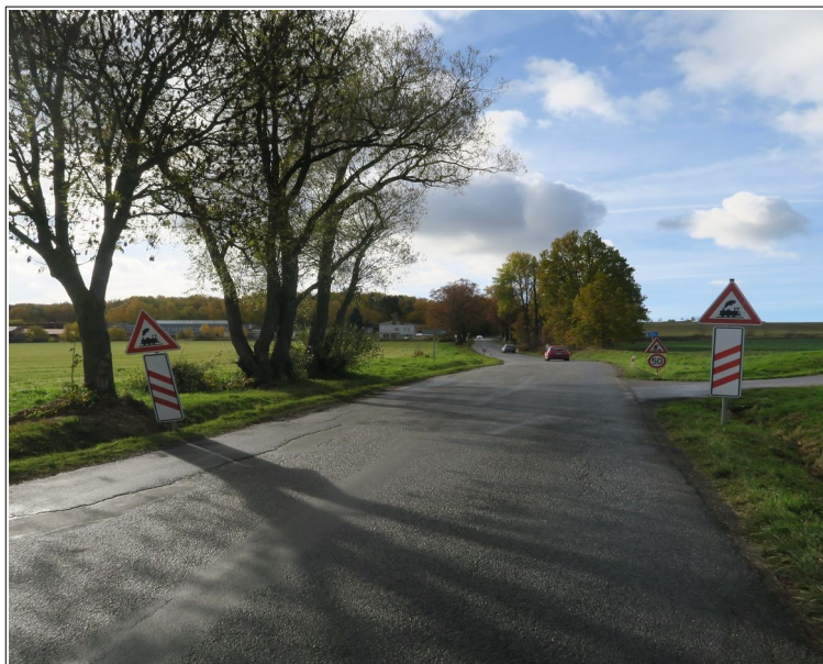
Obr. č. 2: Dopravní značení ve směru jízdy NA
