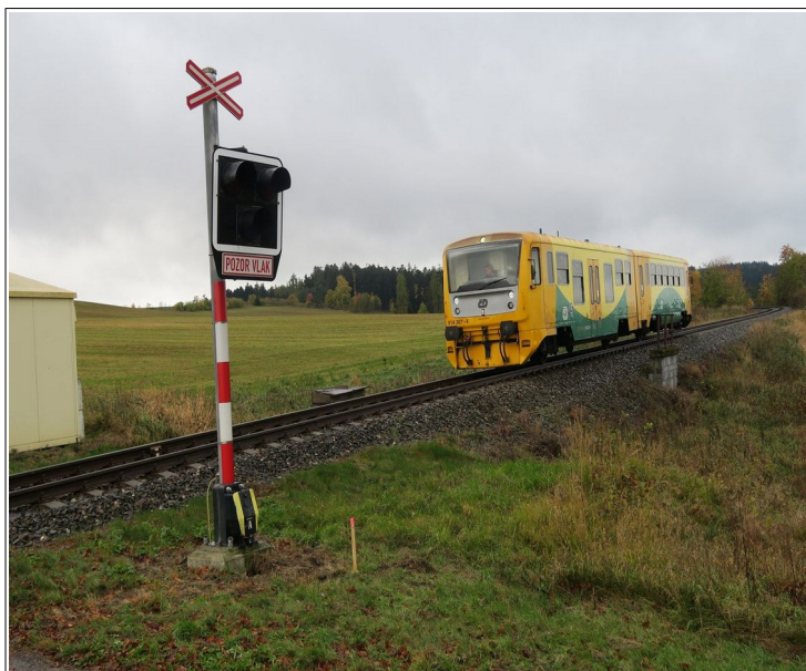
Obr. č. 9: Rozhled z pozemní komunikace na dráhu ze vzdálenosti 6 m od osy koleje Zdroj: D1
