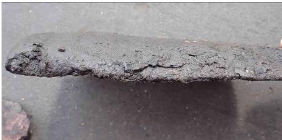
Foto nr.6 – detaliu material izolație termică
