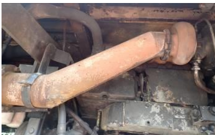
Foto nr.8 – galeria de evacuare gaze arse
