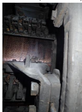
Foto nr.2 Colectorul și coroana port perii a GP
