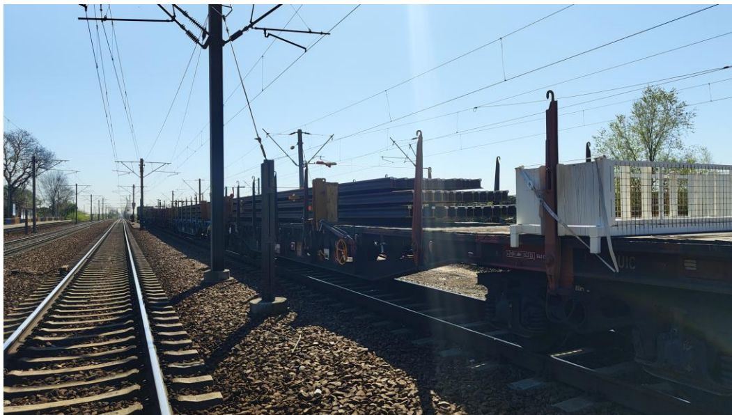
Imaginea nr.16 – poză din poziția laterală cu vagoanele încărcate, cu capătul șinei
