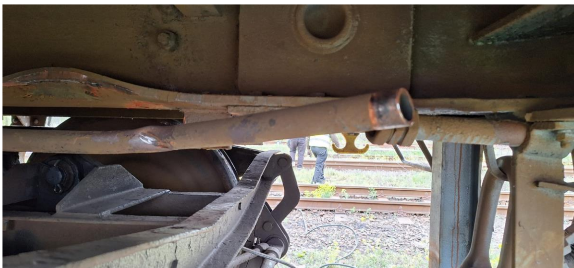
Imaginea nr.9 – deformație locală a longeronului central în zona roții nr.2 (roată găsită pe șină nederaiată) și conducta generală de aer deformată și smulsă din mufa de prindere în două locuri
