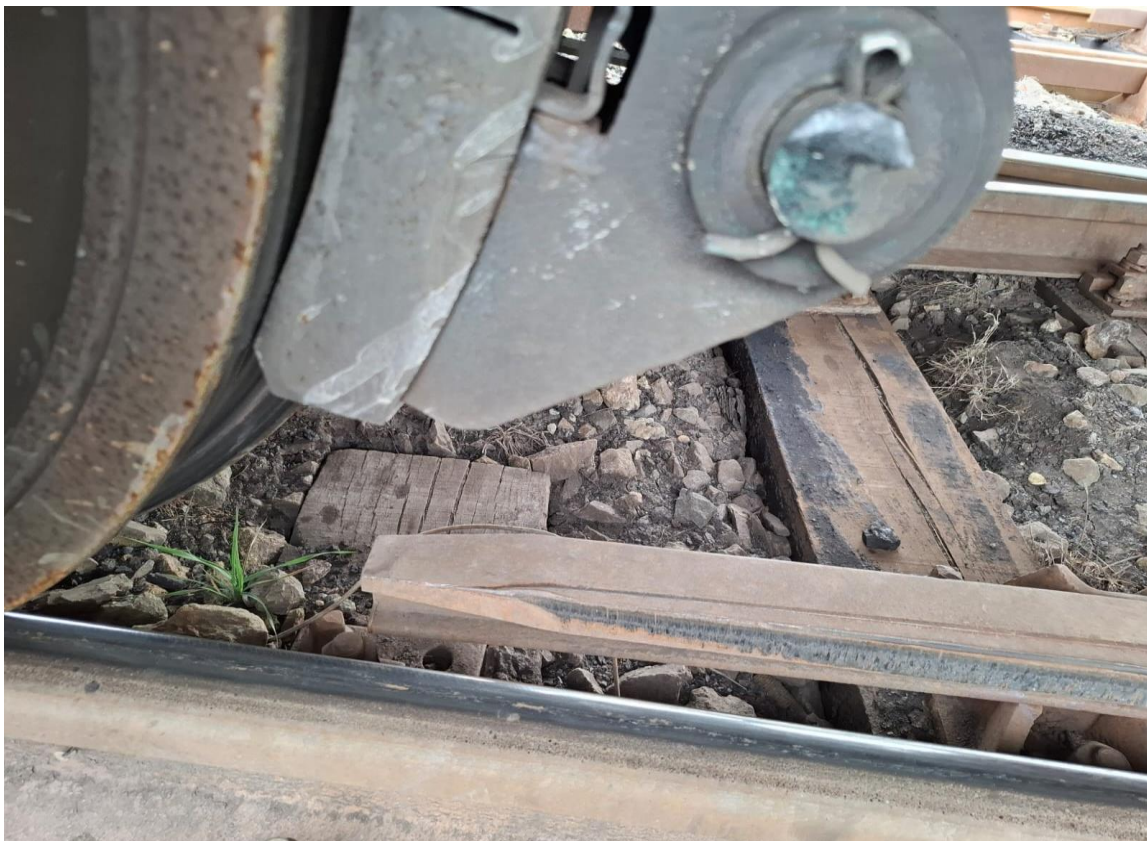
Imaginea nr.4 – escaladarea contrașinei inimii rombului diagonalei 25/33
