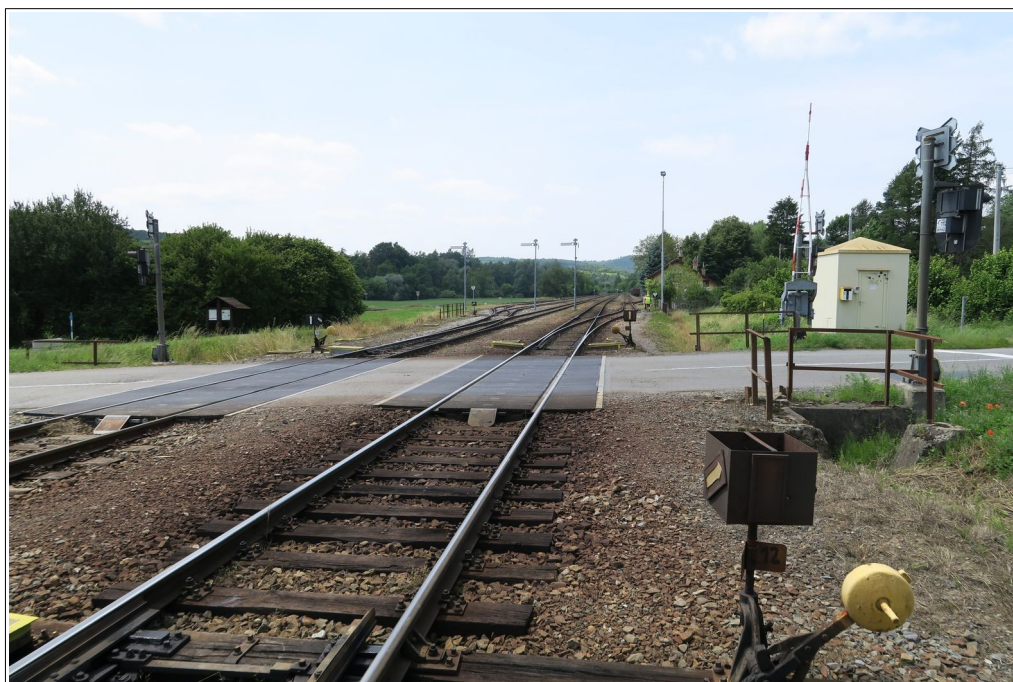
Obr. č. 3: Pohled na 1. SK žst. Nemotice ve směru jízdy vlaku Sp 1767 Zdroj: DI
