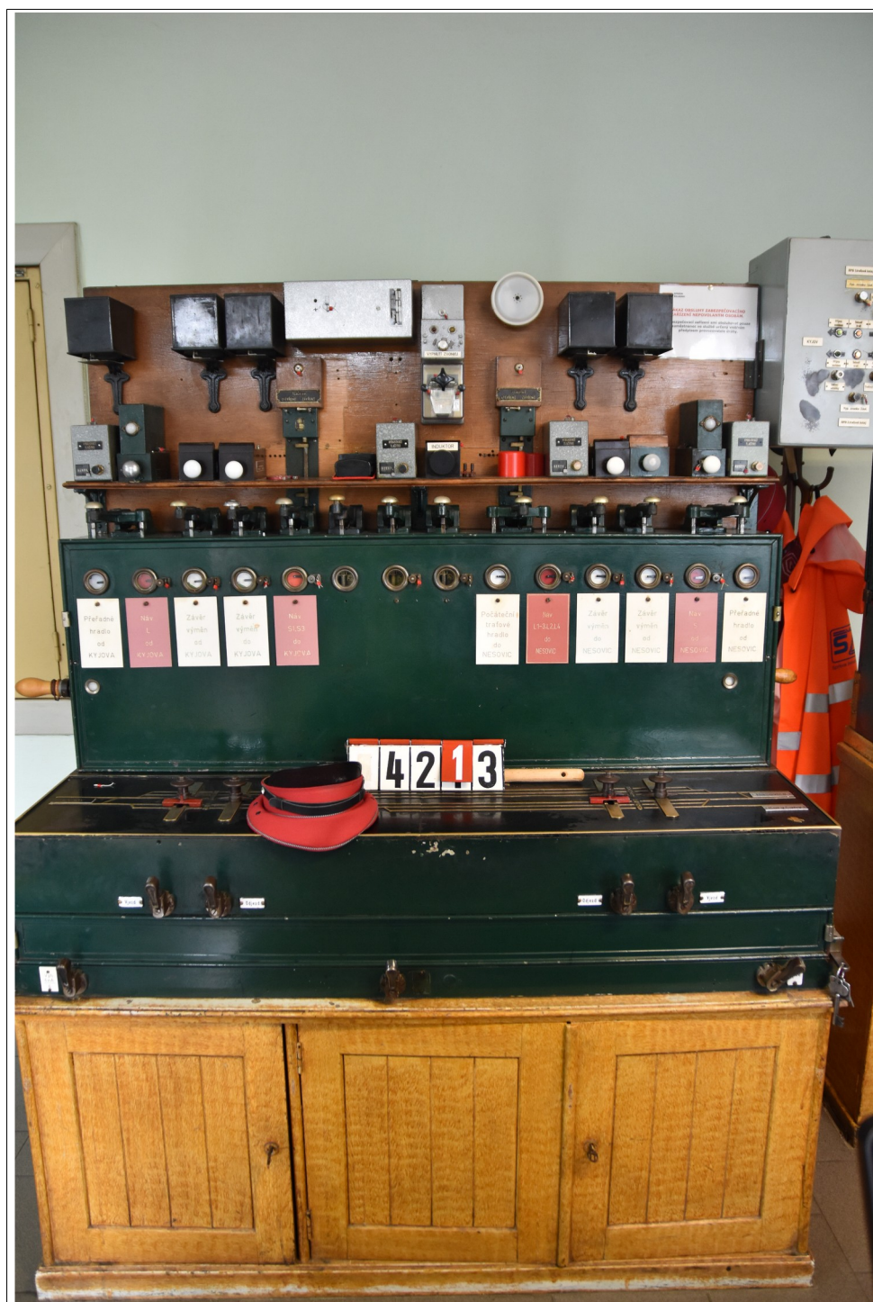
Obr. č. 5: Pohled na řídicí přístroj ZZ v dopravní kanceláři žst. Nemotice
