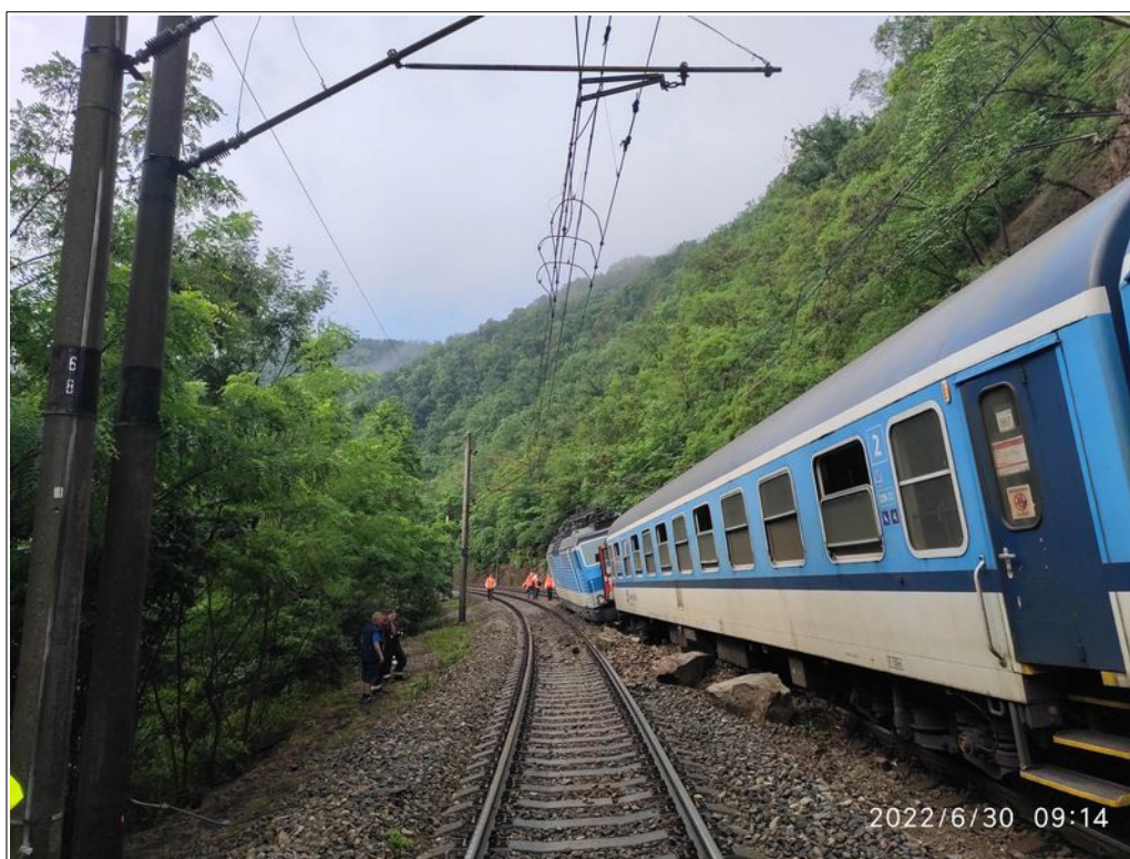
Obr. č. 12: Pohled na místo vzniku MU v km 28,285
