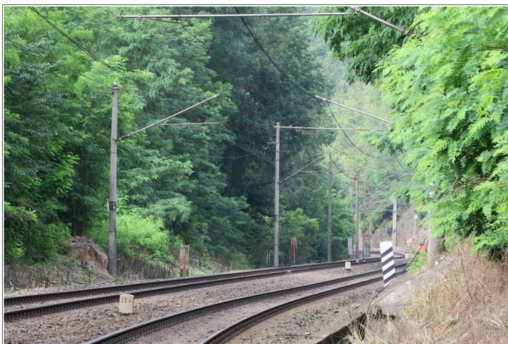
Obr. č. 24: Pohled na místo vzniku MU cca z 379 m (zazoomováno - snímek odpovídá vnímání objektu inspektorem DI) dne 1. 7. 2022 Zdroj: DI
