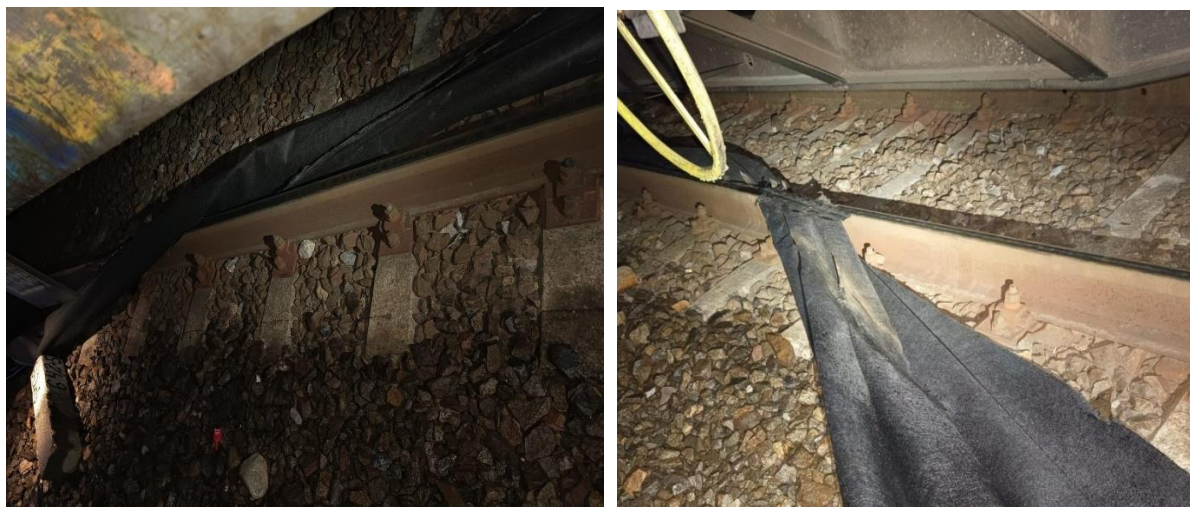
Imaginea nr.6 și 7 – material geotextil lângă șina din partea stânga, în sensul de mers
