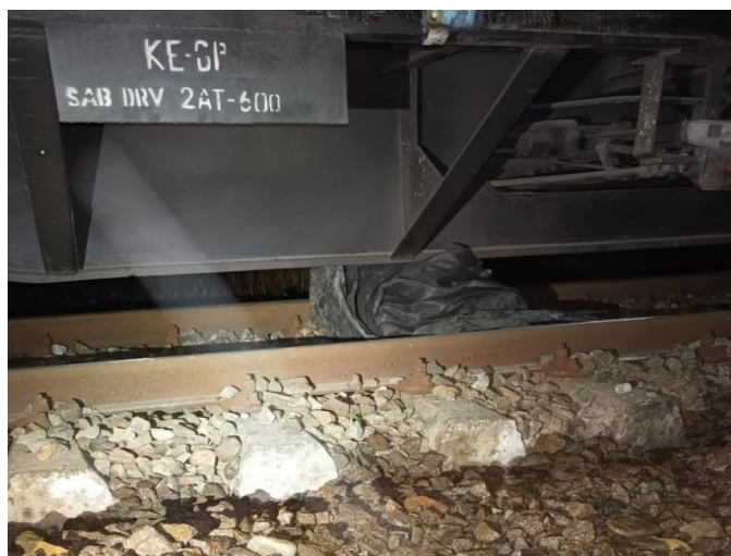
Imaginea nr.14 – material geotextil adunat sub al 17-lea vagon
