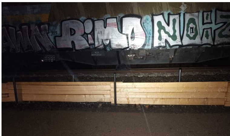
Imaginea nr.11 – sprijiniri, la data producerii accidentului
