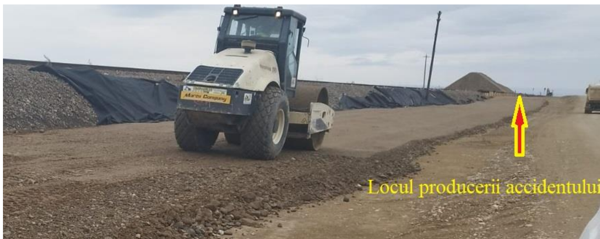
Imaginea nr.10 – lucrări executate la data de 11.03.2025, la km 642+700
