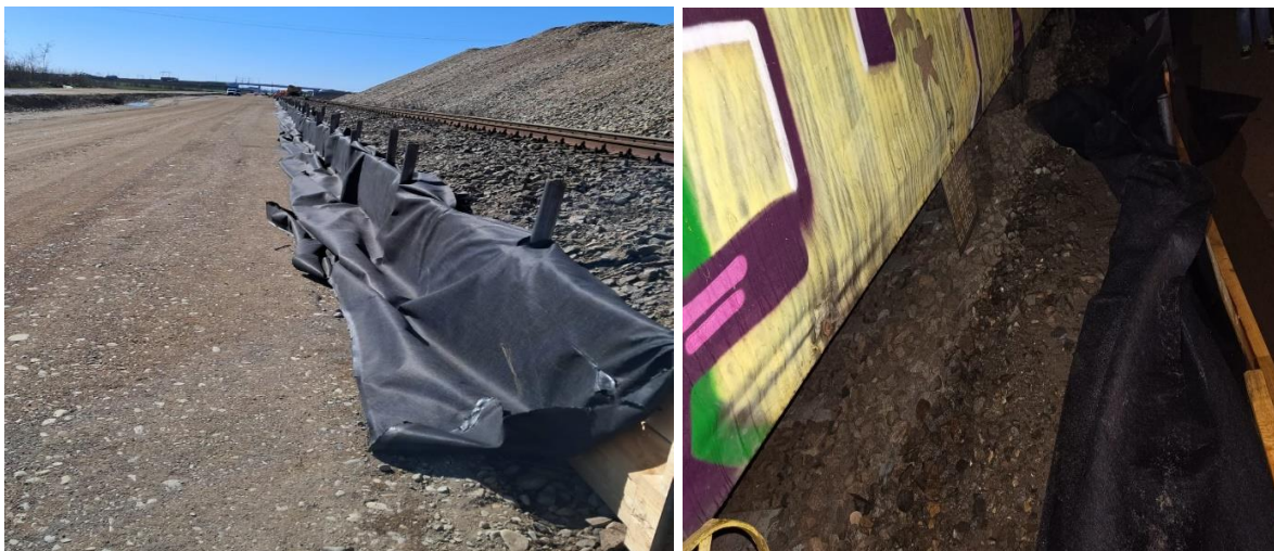
Imaginea nr.12 și 13 modul de punere în operă a materialului geotextil în zona producerii accidentului
