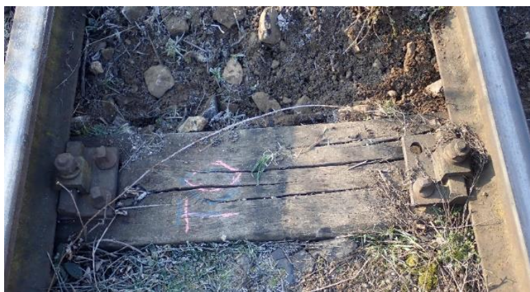
Foto nr.2 Traversa T0
