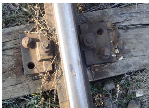
Foto nr.3 Traversa T-1
